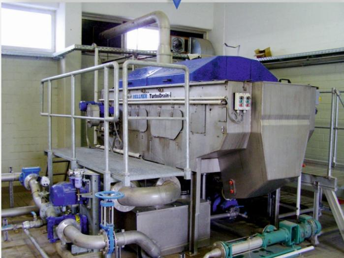
Auch der Überschussschlamm aus den Nachklärbecken findet sein Reiseziel in den Faulbehältern. Die Eindickung dieses Schlammes erfolgt zuerst mit Hilfe des „TurboDrain“ (Bild links) - einer maschinellen Schlammeindickung. Durch die Beimischung eines Flockungshilfsmittels (Polymer) wird die Entwässerungsfähigkeit des Schlammes unterstützt.
