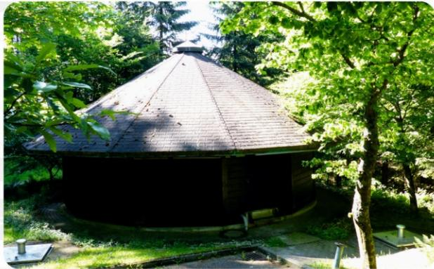
**B**ereits 1982 ging die Anlage in Betrieb und beruht auf dem „Emscher-Prinzip“. Im Inneren des Gebäudes befinden sich Biologie und Nachklärung.
