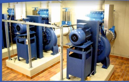
Das aus der Biologie kommende Wasser wird nun zur letzten Reinigungsstufe in die beiden Nachklärbecken transportiert. Die insgesamt drei Kreiselpumpen des Zwischenhebewerks (Bilder links) übernehmen diese Aufgabe. Jede einzelne Pumpe fördert bis zu 570 Liter pro Sekunde.
