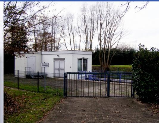
Im freien Gefälle fließt das Abwasser Richtung Kläranlage. Da auf langen Strecken das Gefälle oft nicht ausreicht, muss das Abwasser mit Hilfe von Pump- und Heberwerken angehoben bzw. weiter transportiert werden.
