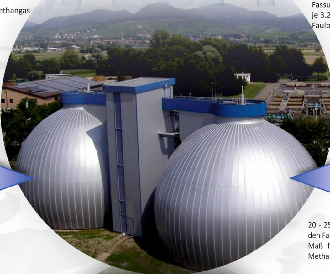
20 - 25 Tage Aufenthalt in den Faulbehältern sind das Maß für den maximalen Methangas-Ertrag.
