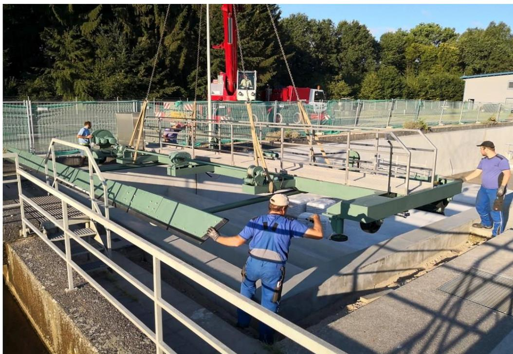
Wiedereinbau des generalüberholten Räumers in das Vorklärbecken nach der Betonsanierung.
