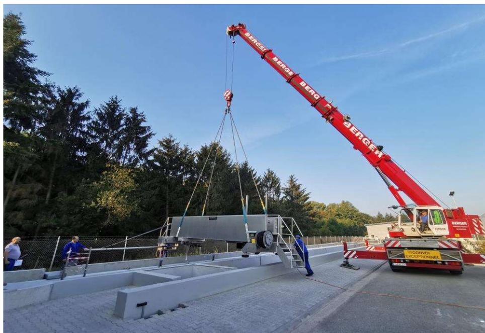
Nach der Sanierung wird der Räumler wieder über den Sandfang gesetzt.
