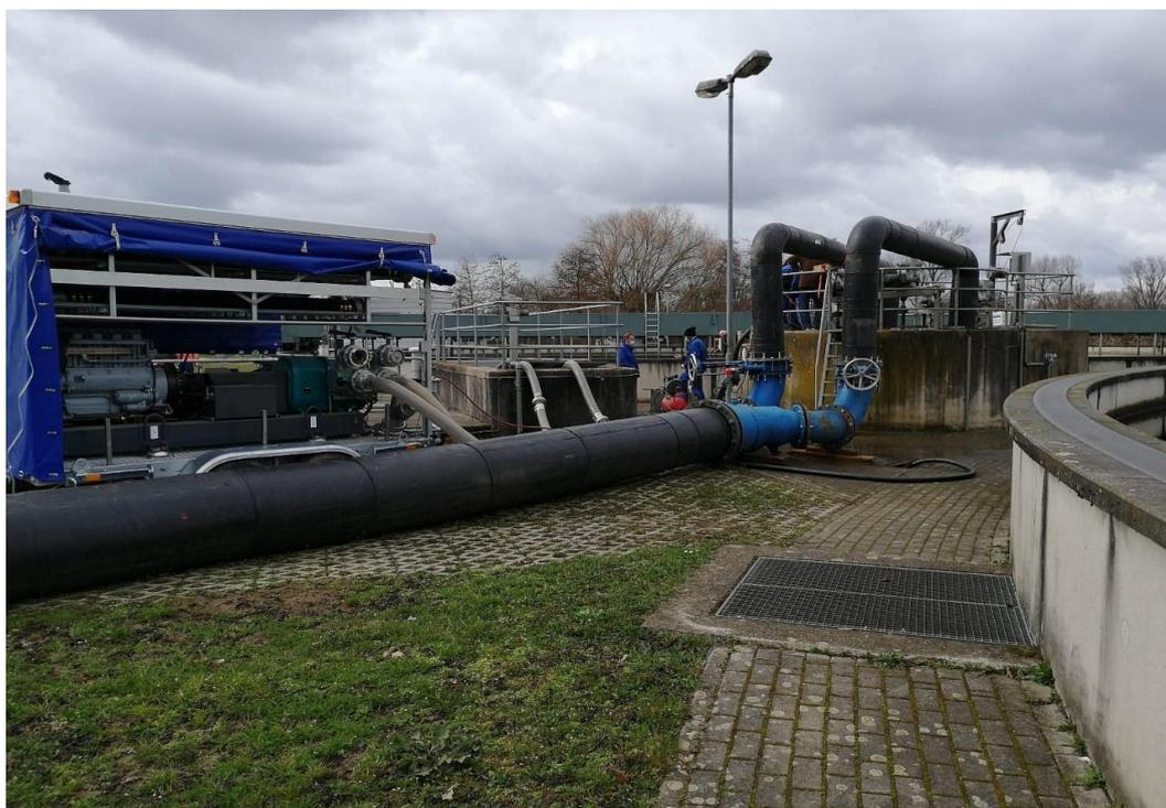
Riss am Einlauf zum Zwischenhebewerk, Bau einer provisorischen Umgehungsleitung
