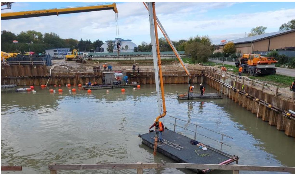
Einbringen des Unterwasserbetons auf der Sohle des Belebungsbeckens
